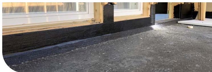
OSB-levytetyn CLT-elementtiparvekkeen vedeneristys
