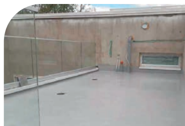
Kattoterassi ElaProof käsiteltynä
