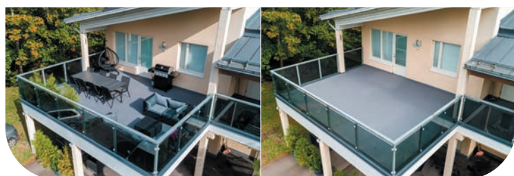
Kattoterassi ElaProof+SAND pinnoitettuna - kalusteilla ja ilman.
