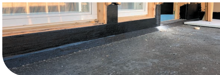
OSB-levytetyn CLT-elementtiparvekkeen vedeneristys
