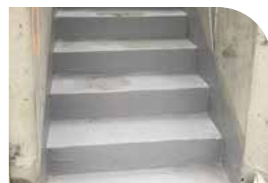
Nylagde trapper før behandling med PU-Sealer
