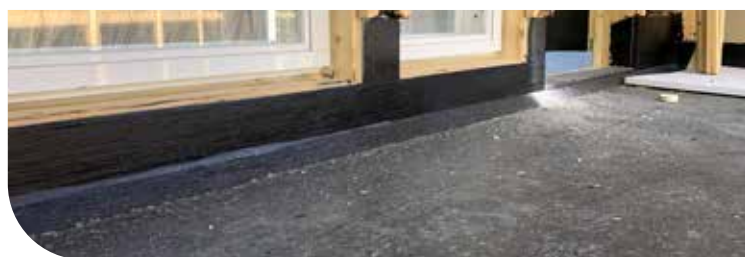
Vanntetting av OSB/CLT prefabrikkert balkong
