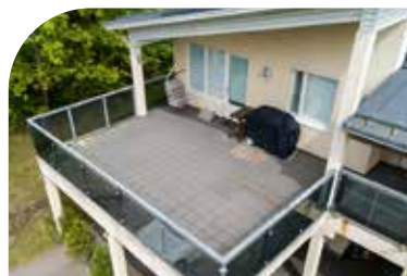
Takterrass inför renovering
