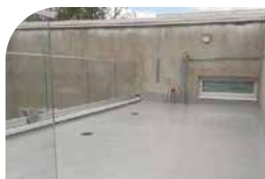
Takterrass behandlad med ElaProof
