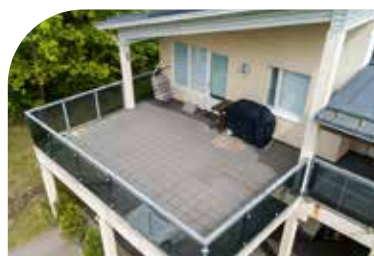
Tagterrace før renovering
