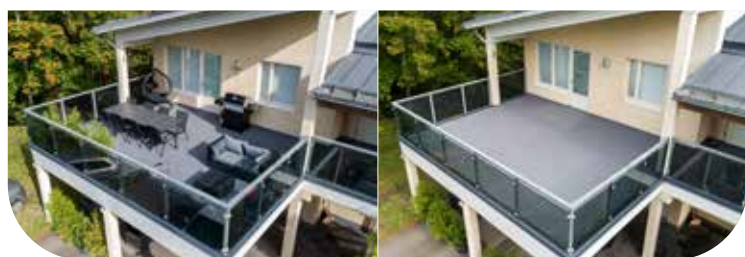
Tagterrace med ElaProof + SAND belægning – med og uden møbler.
