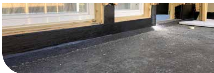
Vandtætning af altan lavet af OSB-plader/CLT elementer
