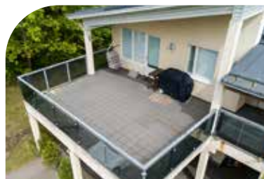
Tagterrace før renovering
