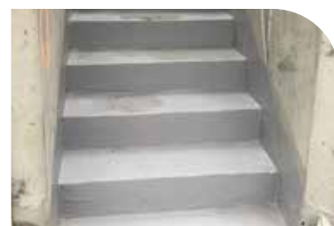
Nylavet trappe før behandling med ELACOAT TopCoat
