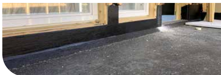
Vandtætning af altan lavet af OSB-plader/CLT elementer
