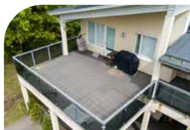
Tagterrace før renovering
