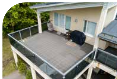
Takterrasse før oppussing
