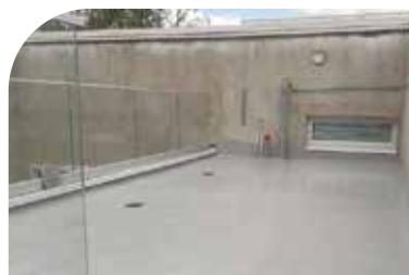
Takterrasse behandlet med ElaProof
