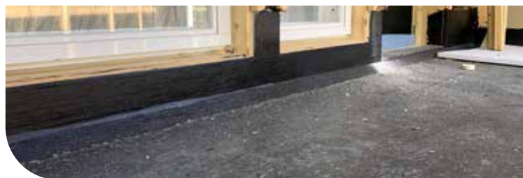
Vanntetting av OSB/CLT prefabrikkert balkong
