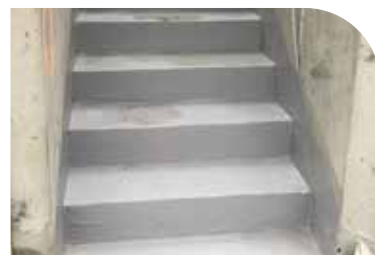
Nylagde trapper før behandling med PU-Sealer
