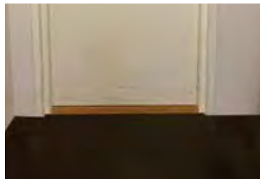
Teknisen tilan lattia
