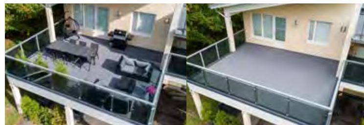
Kattoterassi ElaProof+SAND pinnoitettuna - kalusteilla ja ilman.
