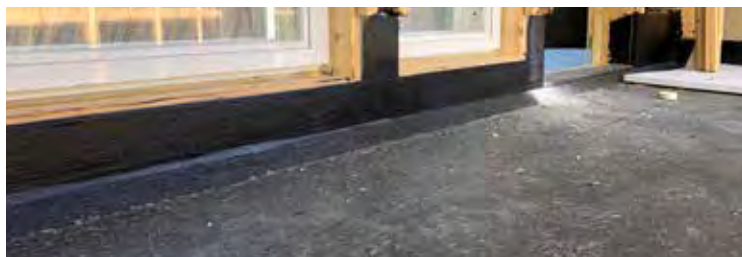
OSB-levytetyn CLT-elementtiparvekkeen vedeneristys
