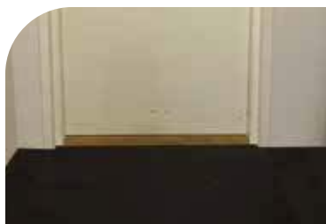
Gulv i teknikrum
