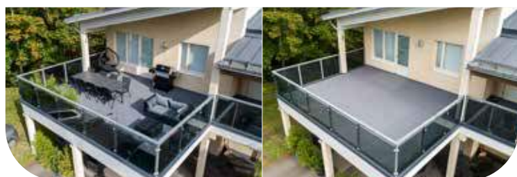
Tagterrasse med ElaProof + SAND belægning – med og uden møbler.
