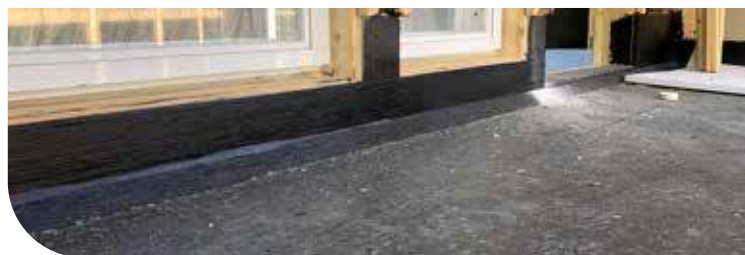
Vandtætning af altan lavet af OSB-plader/CLT elementer
