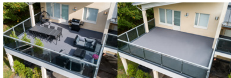
Kattoterassi ELAProof+SAND pinnoitettuna - kalusteilla ja ilman.
