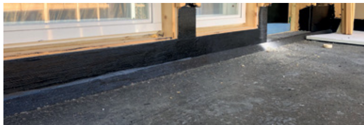
OSB-levytetyn CLT-elementtiparvekkeen vedeneristys
