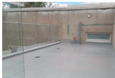
Kattoterassi ElaProof käsiteltynä
